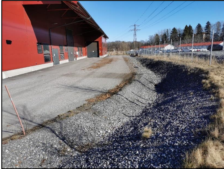
Figur 4. Krossdiket inom värmeverkets fastighet (Säby 1:7).
