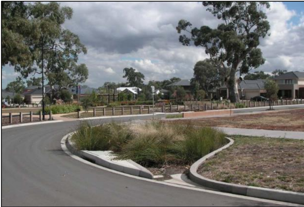
Figur 28. Öppning i kantsten, inlopp till växtbädd (Waterbydesign, 2014)
