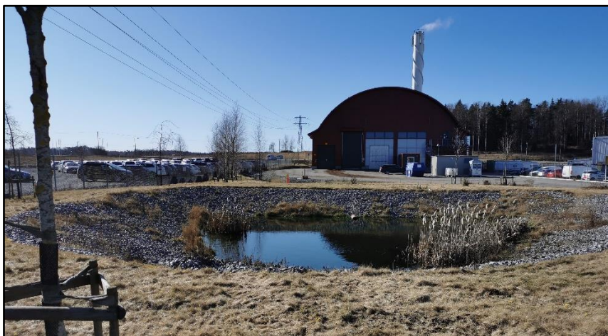
Figur 3. Värmeverk, uppställningsytor och dagvattendamm för fördränning (i fastighet Säby 1:7).
