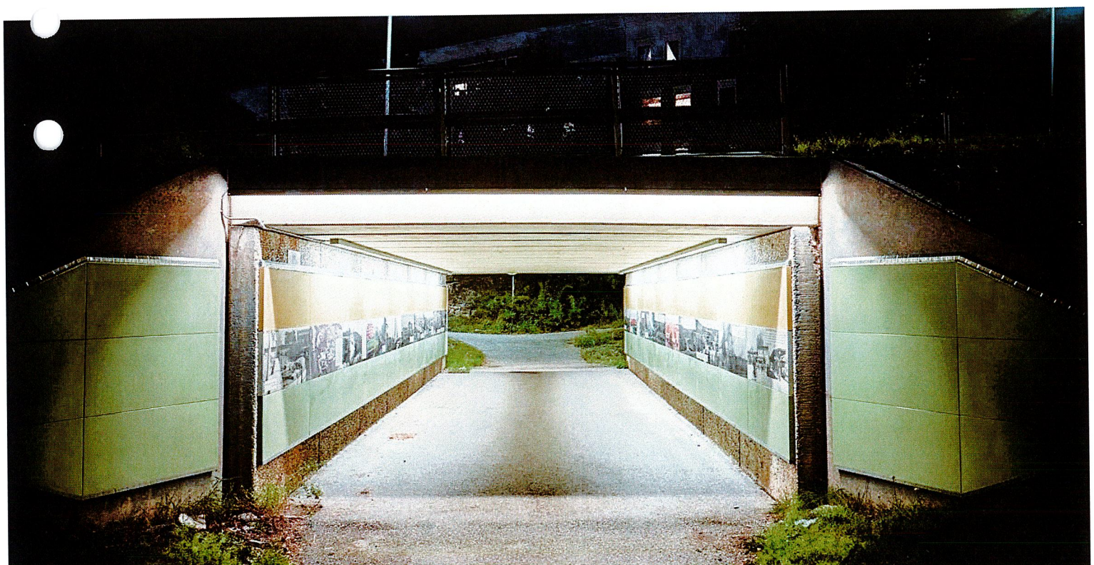
C-tunnel under Norrgårdsvägen i Akersberga. Belysta brovågar och väggar tillsammans med belyst vegetation utanför tunneln, skapar bra förutsättningar för en trygg och säker
