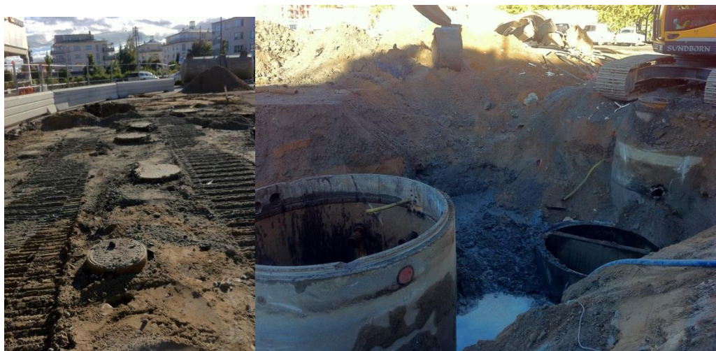
Figur 10. Den vänstra bilden visar område för oljeavskiljare. Den högra bilden visar de olika kammarna för avskiljaren samt förorenad jord kring dessa.
