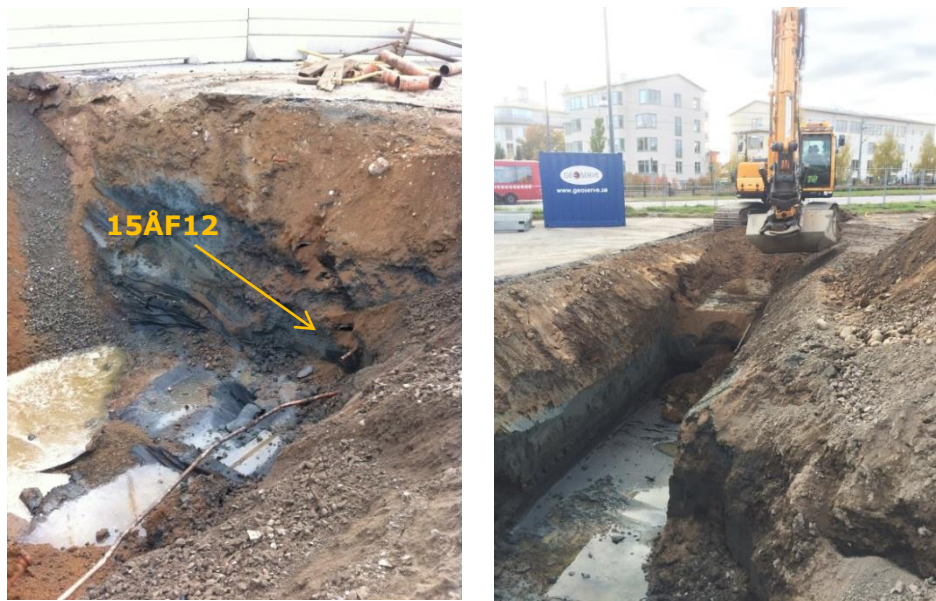
Figur 12. Den vänstra bilden visar gropen där cisternen 6 låg samt där dagvattenledningar mynnar ut och där förorening påträffats. Den högra bilden visar schaktning längs med ledningsstråk där förorening påträffats.
