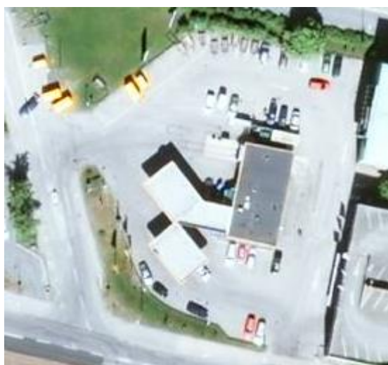
Figur 2. Flygfoto över anläggningen. Källa: Eniro © Lantmäteriet Medgivande R50103251_140001
