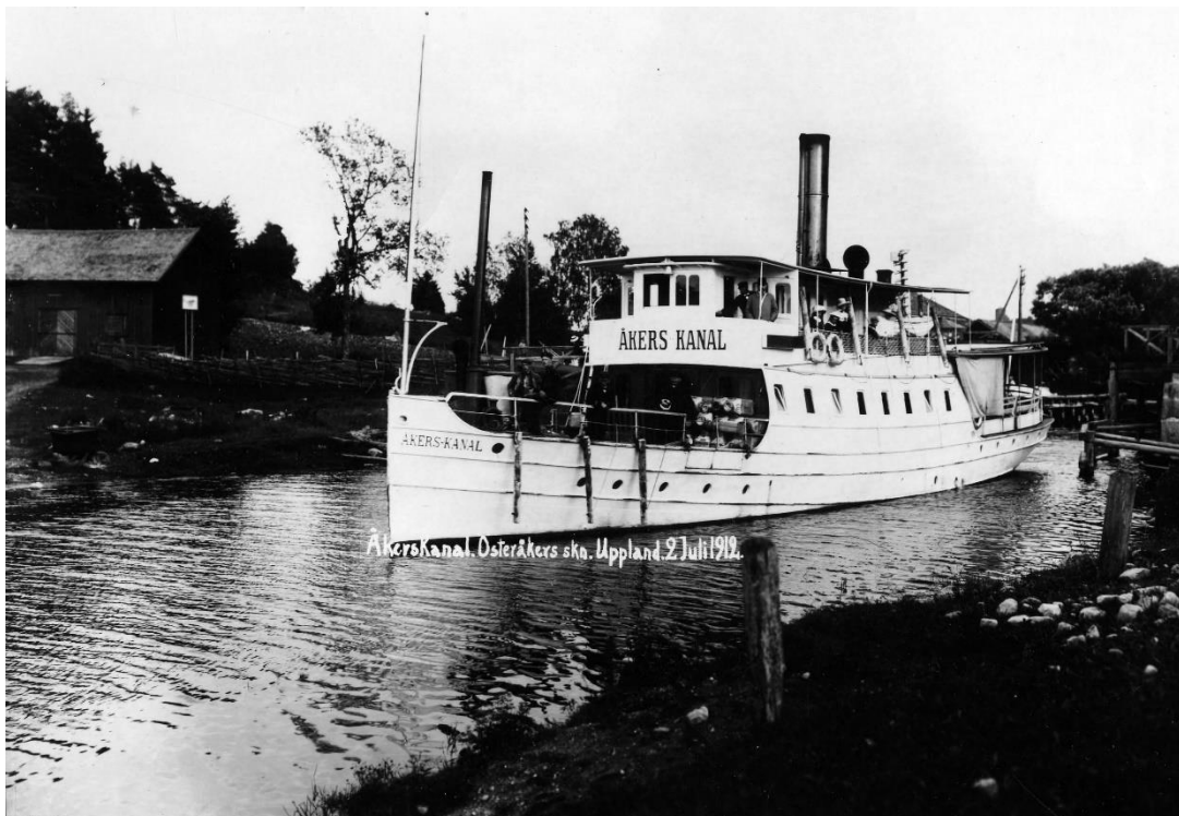
"Åkers kanal" har just passerat bron vid Åkersbro. Till höger i bild skimtar brofundamentet på östra sidan kanalen. På västra sidan kanalen syns handelsboden.
