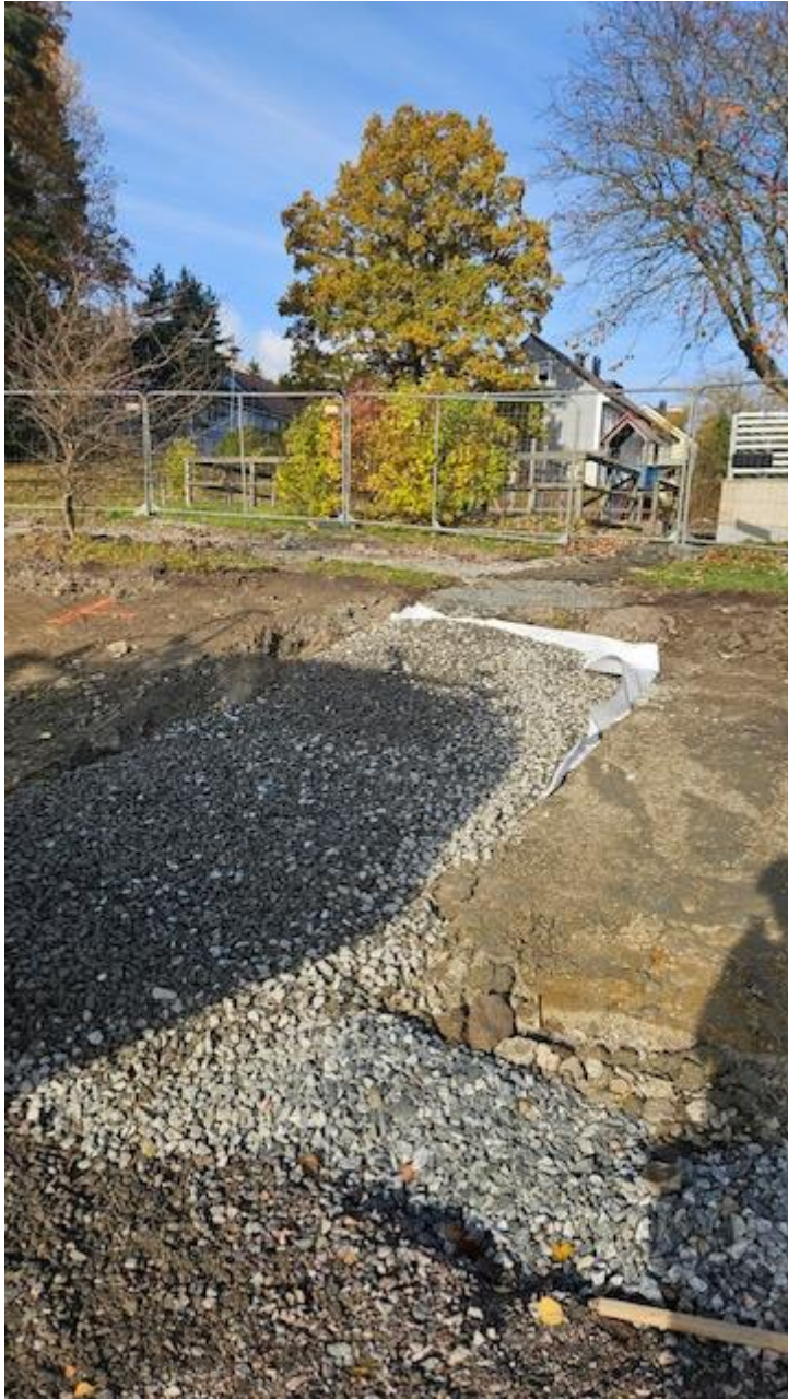
Grundläggning för trappa vid bollplanen
