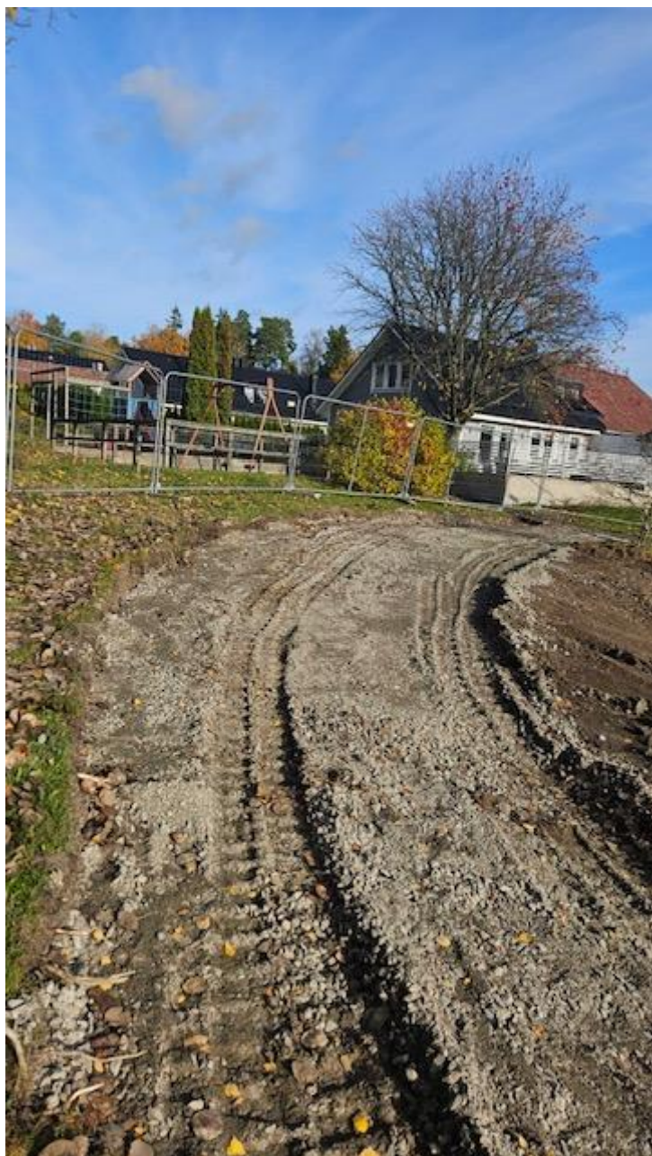
Stenmjölsstig som ansluter ny trappa vid bollplanen
