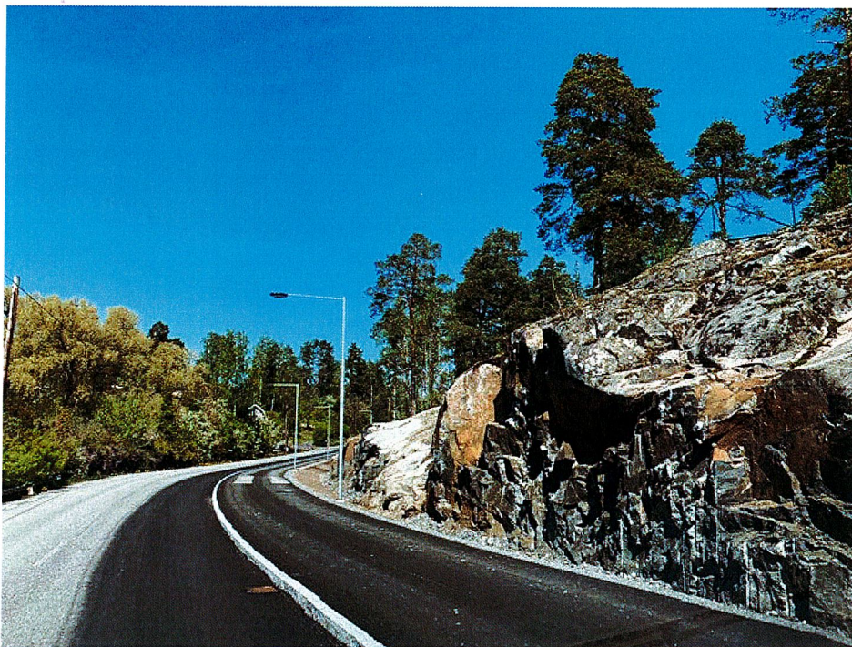
Figur 5. Ny gång-och cykelbana i projektet Margretelundsvägen etapp 2.
