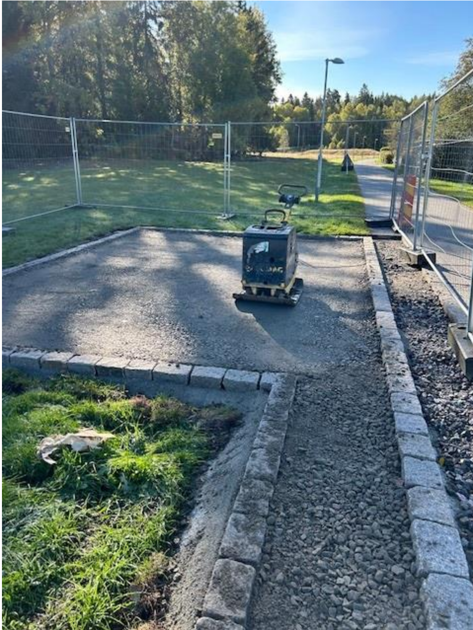
Schakter som ska börja byggas upp med olika material
