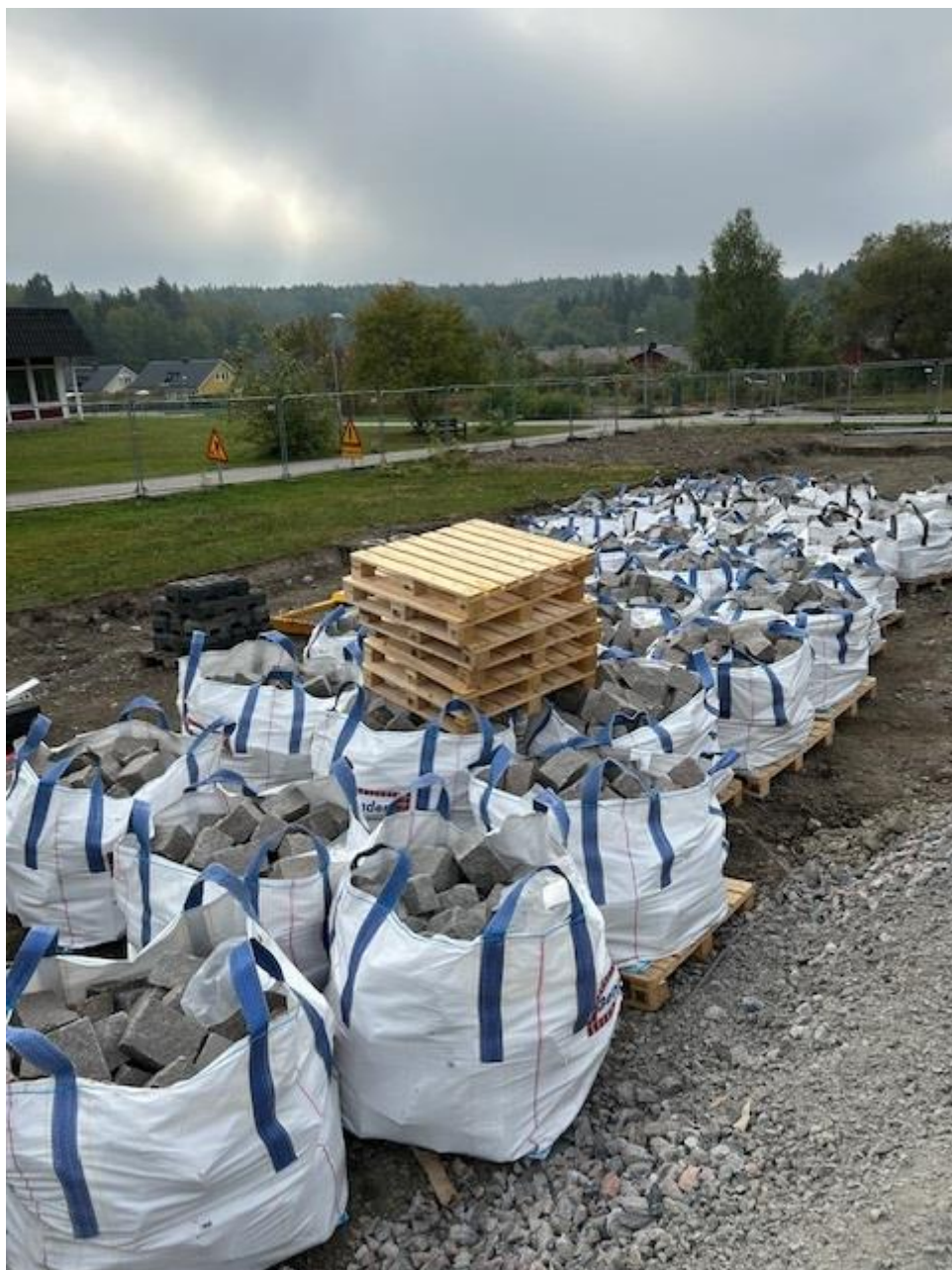
Fundament till belysning vid Trollskogen
