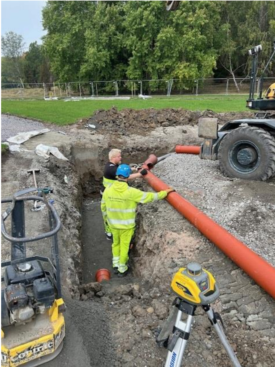
Läggning av rör runt bollplanen
