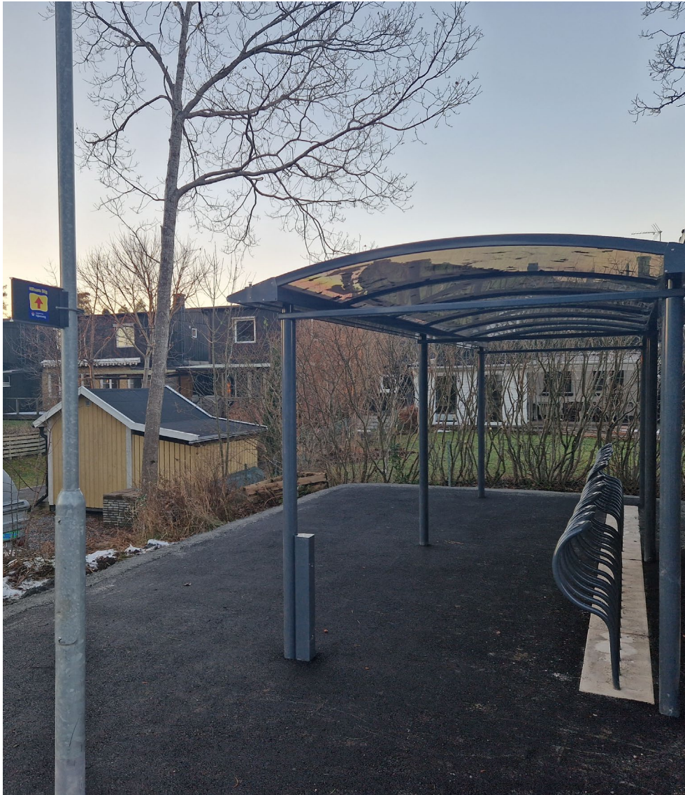
Figur 5. Ny cykelparkering vid bussbållplats Skogsrundan.
