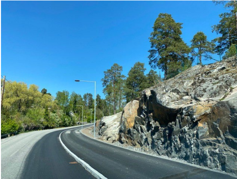
Figur 5. Ny gång-och cykelbana i projektet Margretelundsvägen etapp 2.
