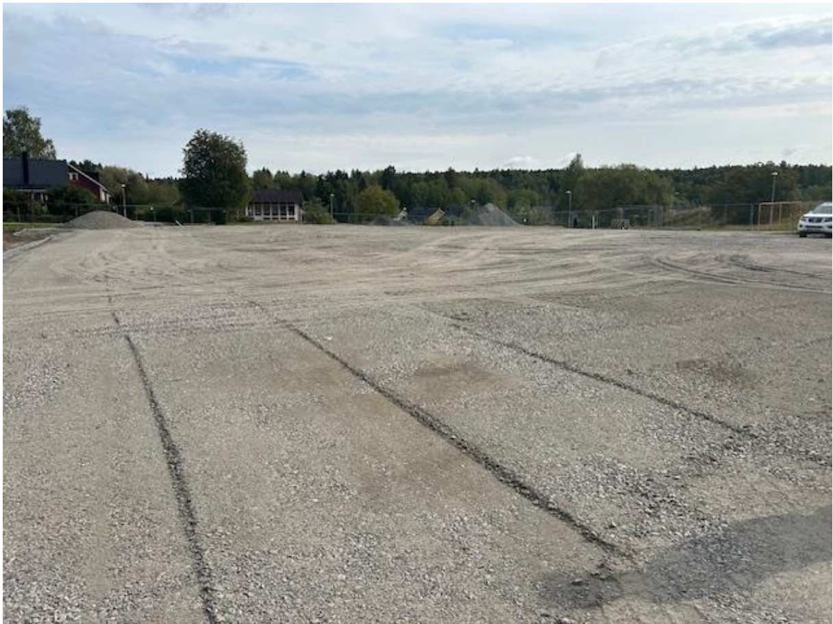
Schakt utmed långsida av bollplanen
