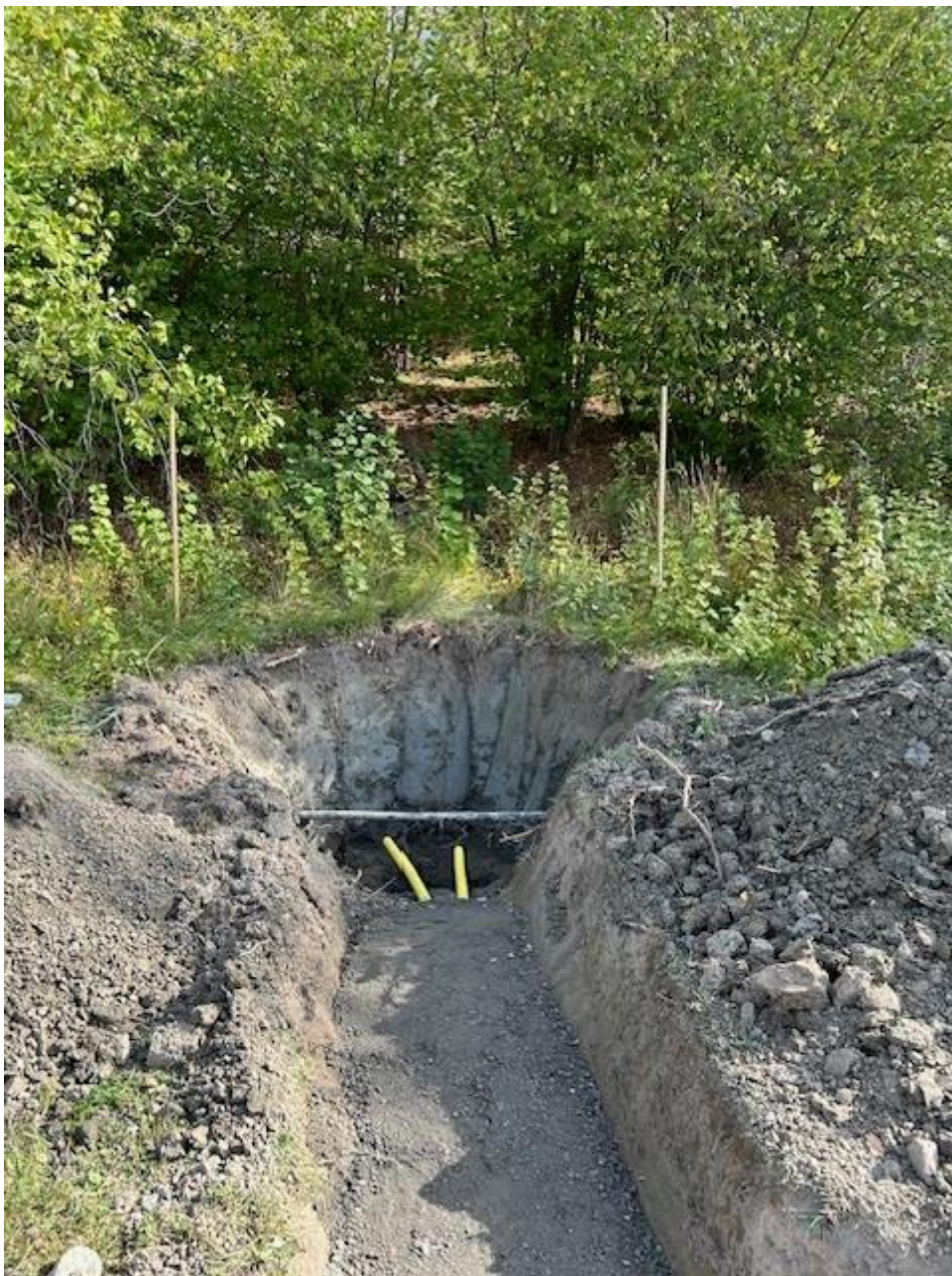
Schakt för nytt fundament nedanför Trollskogen
