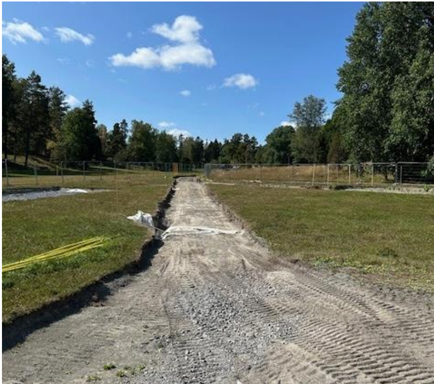
Schakt för gångstig mellan bollplanen och Murkelvägen
