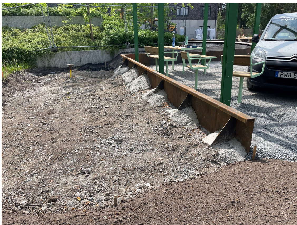
Baksidan av cortenstål kantstödet
