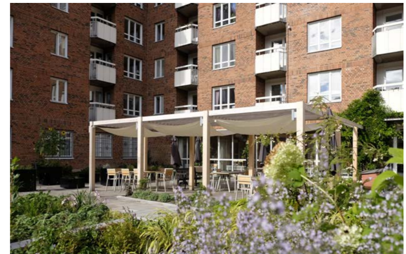
Exempel på zon 2, skyddade sittplatser under pergola i direkt anslutning till vårdbyggnaden, Trehörningens äldreboende
