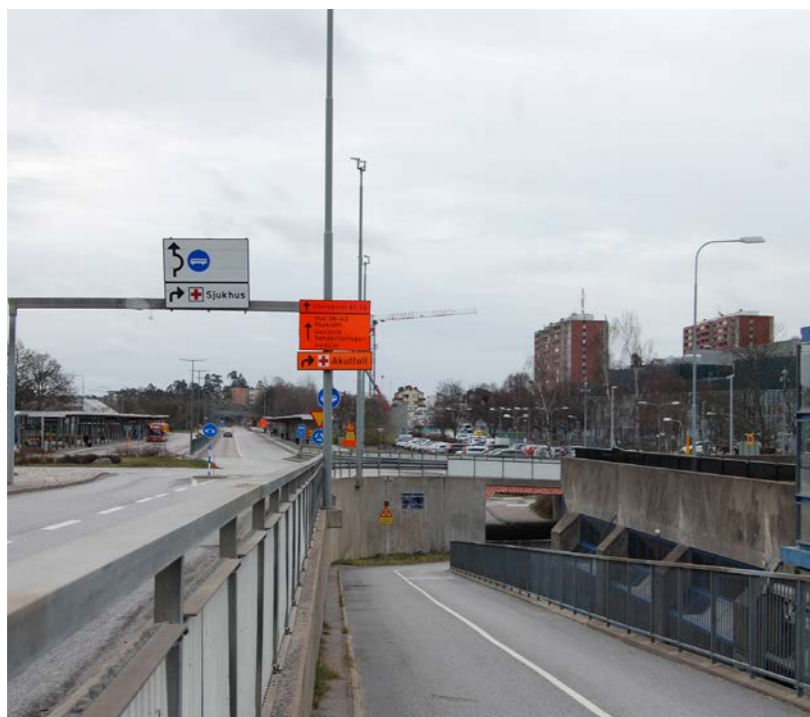
Gång- och cykelstråket längs med Mörbygårdsvägen, vy mot tunneln under Vendevägen, foto & Rundquist
