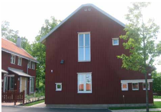
Enkel byggnadsvolym där de vertikala fönstren ger byggnaden en tydlig och karaktäristisk gavel. (Mariefred. Arkitekt: Torbjörn Almqvist AIX).
