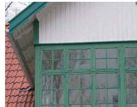
Äldre fönster med små rutor, smäcker konstruktion och äldre, sannolikt munbläst glas.
