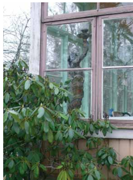
Husets ursprungliga fönster utgör en otroligt viktig del av byggnadens arkitektur. Äldre fönster tillverkades så gott som undantagslöst av utvalt kärnvirke. Dessa fönster är lätta att underhålla genom kontinuerligt underhåll och har mycket lång livslängd.
