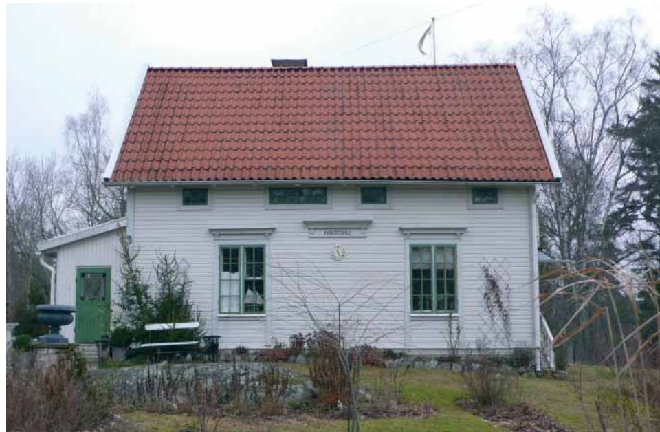
Byggnaden har brant takfall (d.v.v relativt brant tak) med lertegelpannor. Huset "står på" berget och följer terrängen. Mindre byggnadsdel till vänster underordnar sig i skala. Huset har symmetriskt placerade fönster. Fönster, panel, färg och detaljer samverkar till en arkitektonisk, väl avstämd, helhet.
