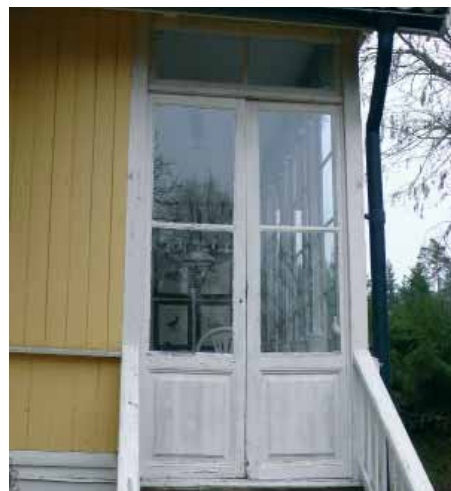
Verandadörr med uppglasade fyllningar (speglar).
