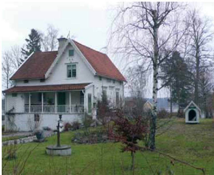
Husets fasader är väldigt viktiga för helhetsintrycket. Om huset bevarar ursprunglig panel bör man försöka undvika utvändigt tilläggsisolering och rusta fasaderna genom att byta skadade delar.
