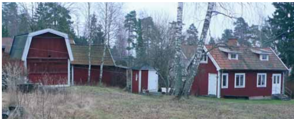
Vivehäll på Portos väg 4 är en äldre odlingsanläggning där äretrunboende odlade frukt och grönsaker för att sälja till sommargästerna vid tiden kring sekelskiftet. Fastigheten är klassificerad som blå.
