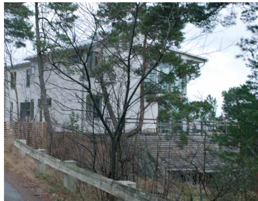
En större veranda omsluter byggnaden. Den liggande träpanelen täcker utbyggnaden och döljer de underliggande mörka partierna. (Villa, Saltsjöbaden)
