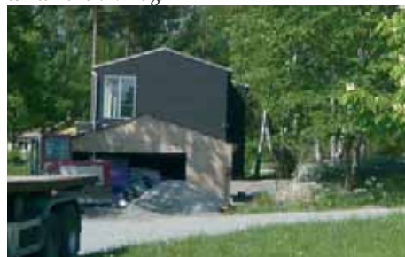
Ett tvåbilsgarage placerat i samma riktning som huvudbyggnaden, och målat i samma färg, gör att garaget tillsammans med huvudbyggnaden bildar en väl utformad helhet.
