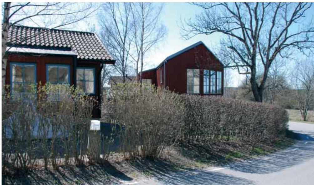
Den äldre och den nya byggnaden är sins emellan mycket olika men har den rödfärgade träfasaden som gemensamt överordnat tema (Håbo Tibble , Arkitekt Sven Olov Nyberg).
