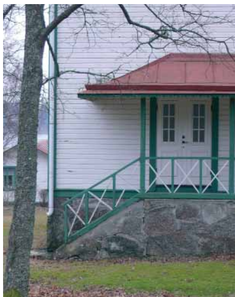
Tydlig grund av natursten med en markerad sockellinje, s.k. vattbräda, målad i en avvikande färg
