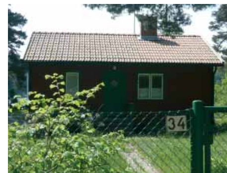
Typisk sportstuga från 1950-talet. På 1930-talet köpte olika byggföretag upp marken i Svinninge men det skulle dröja ända till 1950-talet innan många fastigheter bebyggdes. Sportstugan uppfördes med traditionella material såsom träkonstruktioner och tak av rött lertegel.
