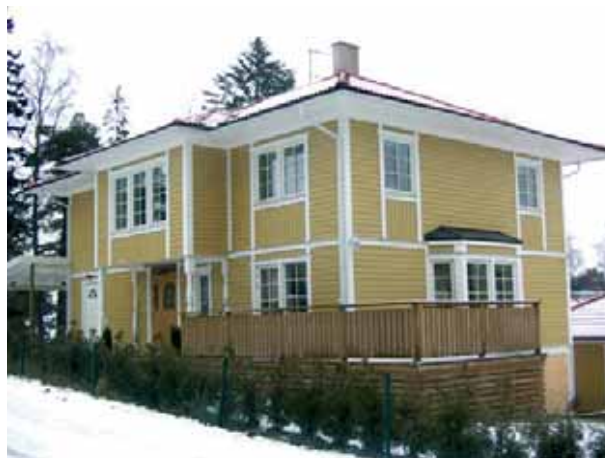
En större 2-våningsvilla i äldre stil med varierad panelsättning. Den stora byggnadsvolymen hålls samman av det tydliga taket och den horisontellt liggande panelen. (Allmogehus)
