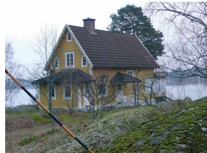
Genom att använda traditionella och beprövade material såsom oljefärg till äldre bostadshus och rödfärg på uthus och ekonomibygnader behåller man husets ursprungliga karaktär.
