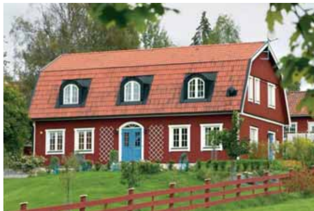
Ytterligare exempel på en större trävilla i äldre säteristil med central-axel och symmetrisk fönstersättning. Byggnadsvolymen minskas genom att det valmade taket utgör en stor del av utformningen. (Sjödalshus)
