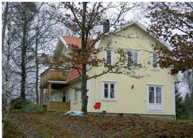
Exempel på trävilla som varsamt smugits in mellan befintliga träd. Byggnaden är utformad i äldre stil och på långt håll är det inte mycket som berättar att den är helt ny. (Alingsås trähus)
