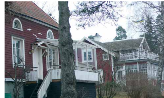
Takens utseende spelar en stor roll för upplevelsen av bebyggelsen. Vid ev. lagning av skadat tak bör man välja lertegelpannor som åldras på ett vackert sätt istället för betongtegelpannor.
