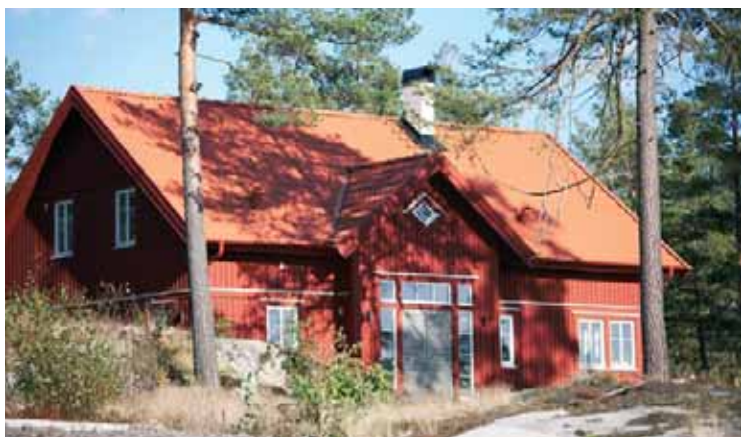
Traditionellt utformat trähus med förhöjt väggfiv och ett accentuerat entréparti. Byggnadsvolymen hålls samman genom att detaljerna är målade i samma röda kulör som fasaden. (a-hus)
