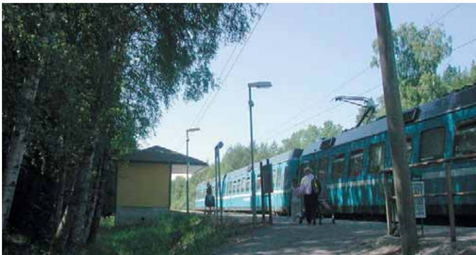
En upprustad Roslagsbana kommer att kunna erbjuda ett attraktivt alternativ till bilen. Täljö station idag.
