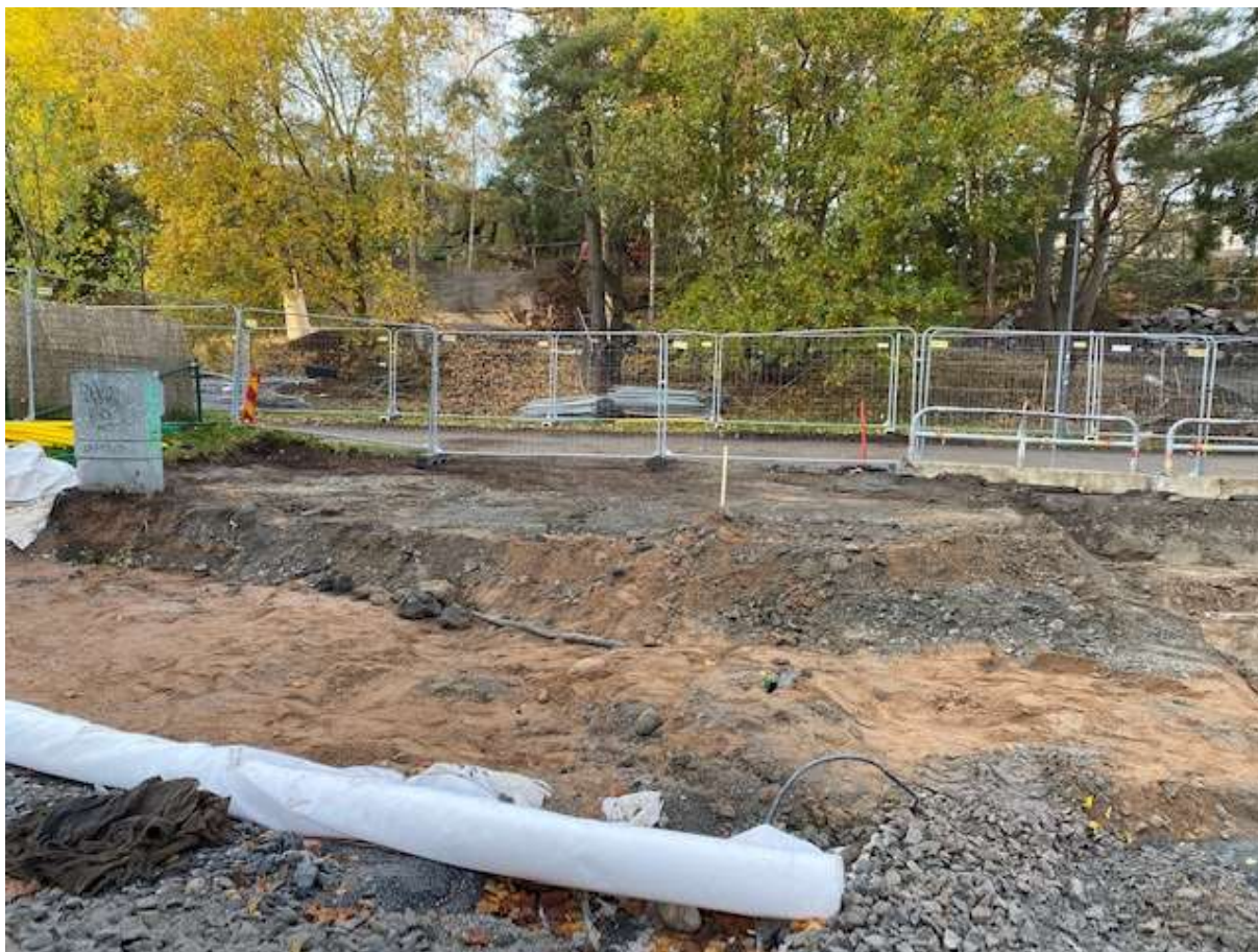
Arbetet på stora planen går vidare med schakt, läggning el och dagvattenrör mm. Det är inte långt kvar där nu med grundläggningen för nya parken.
