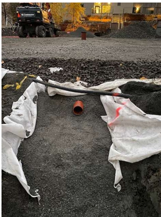
Arbetet på stora planen går vidare med schakt, läggning el och dagvattenrör mm. Det är inte långt kvar där nu med grundläggningen för nya parken.
