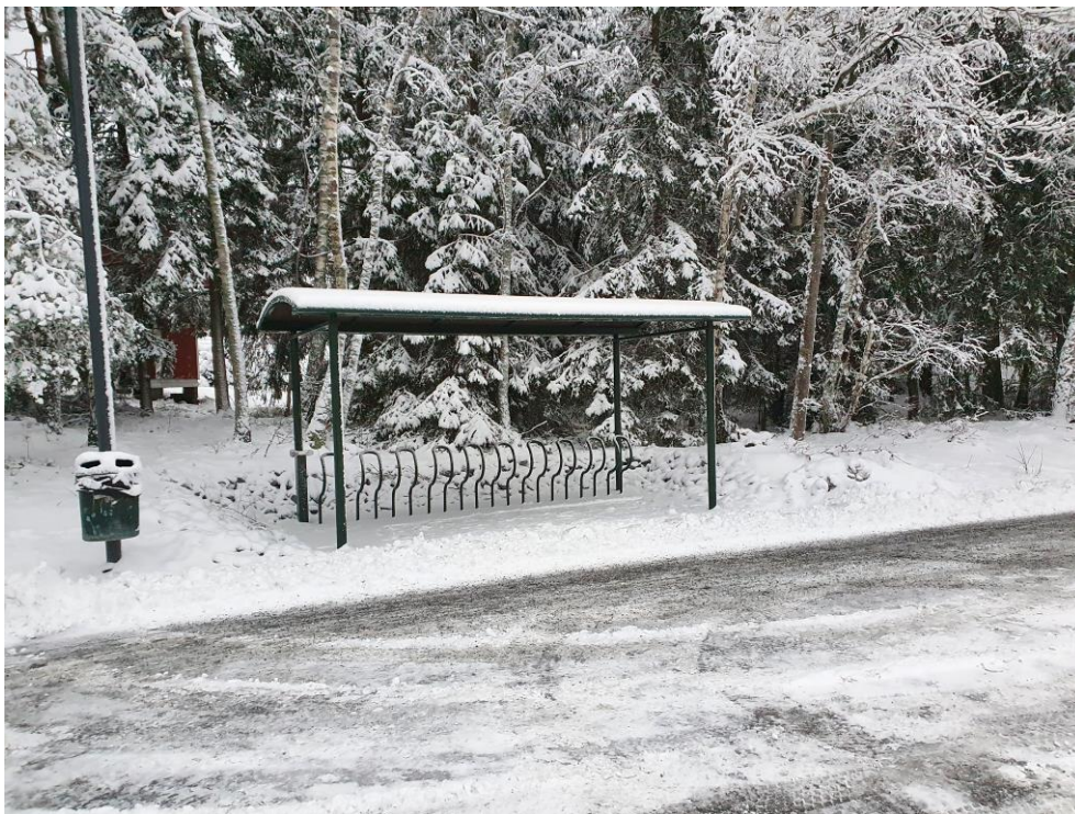
Figur 4. Ny cykelparkering vid Tråsättra busshållplats.
