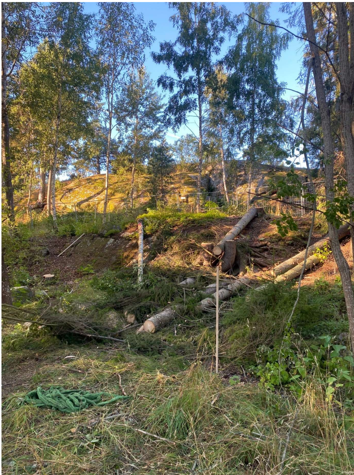
På bilden är entreprenören i full gång med att ta hand om fällda träd på den plats där det ska anläggas en ny släntrutschkana.
