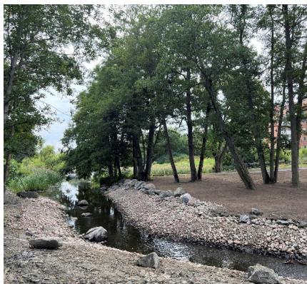
Anläggning av åtgärder för stabilitetsförhållanden, i närhet av Slussen.
