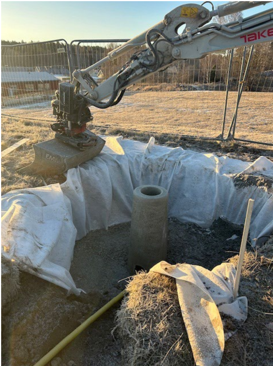
Belysningsarbeten på kullen
