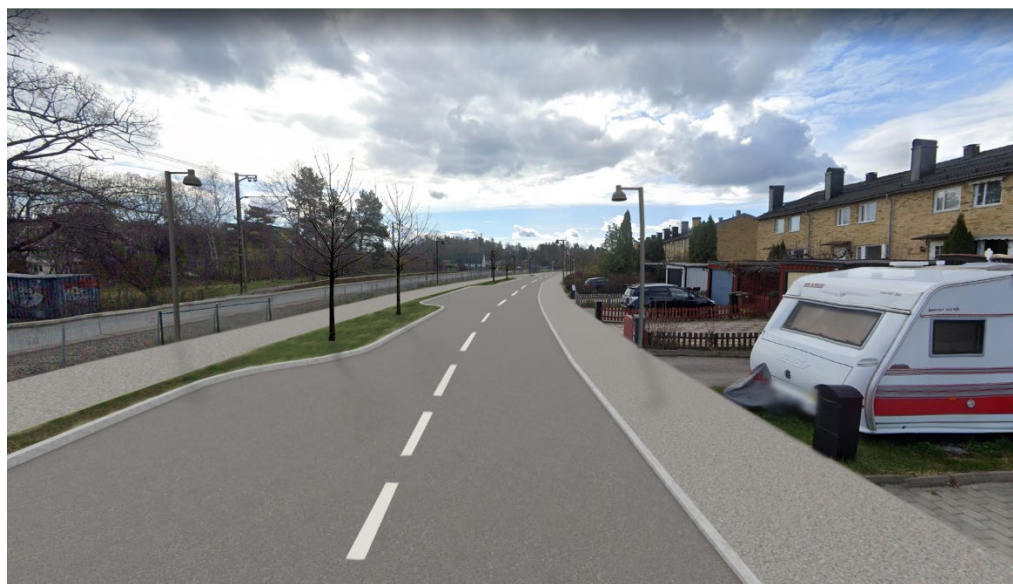
Figur 24. Vy längs Västra Banvägen i område 6, vid radhusen
