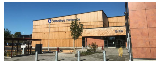
Multiarenans entré mot Företagsallén.
