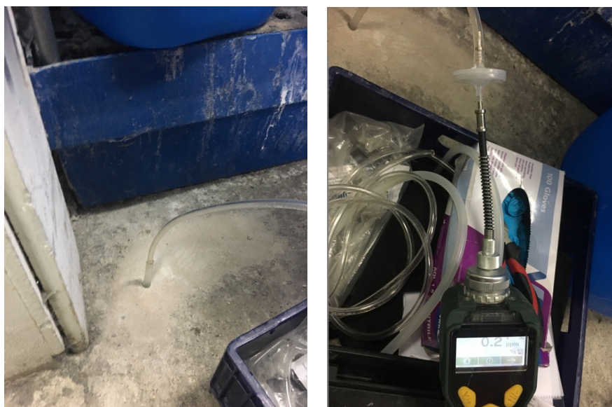
Figur 12. Bilder från provtagning och fältanalys av porluft under bottenplatta
