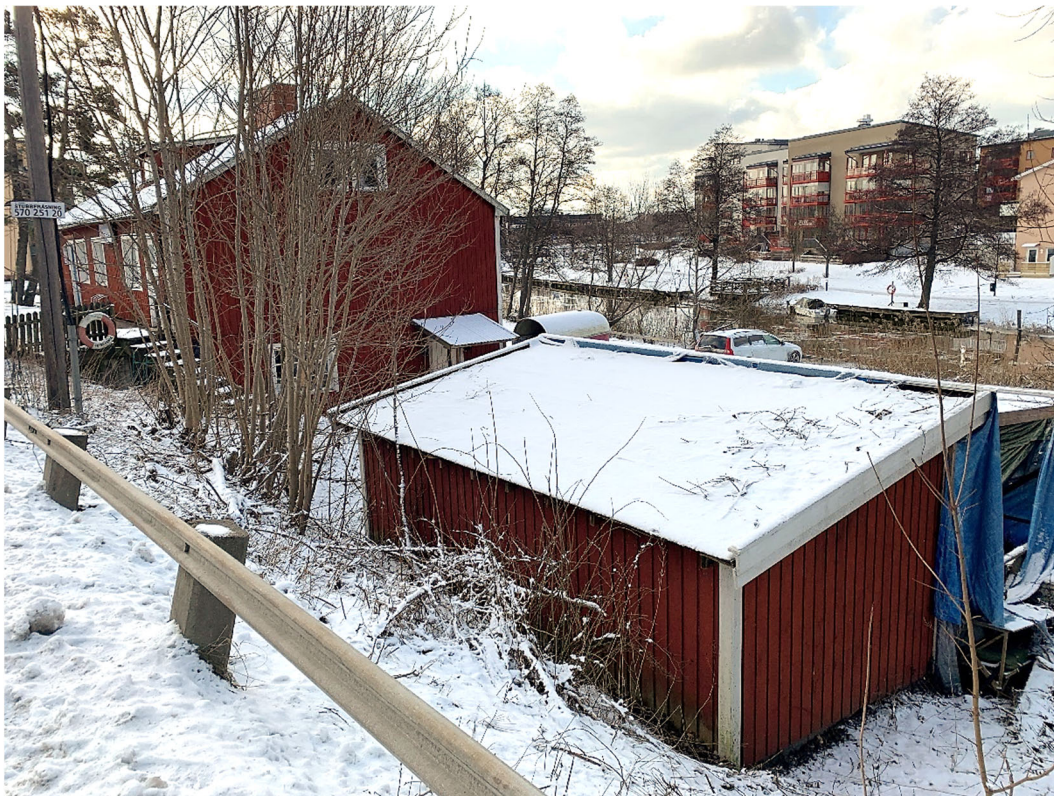
Fastigheten Berga 11:20 i vy från nordöst med uthuset, kanalens vatten och flerbostadshusen väster om kanalen.
