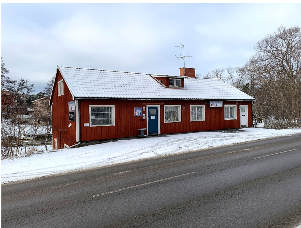
Byggnaden inom fastigheten Berga 11:20 i vy från sydöst.
