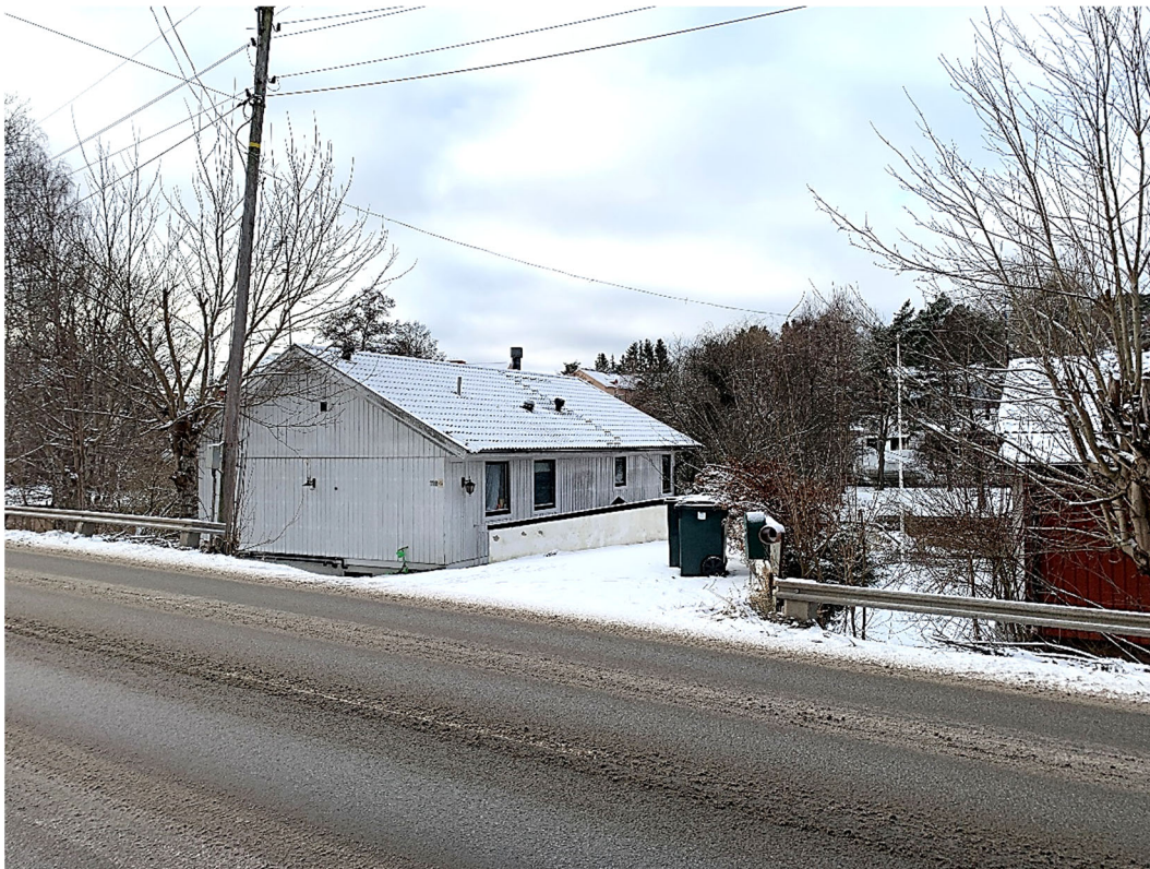
Bostadshuset inom fastigheten Berga 11:76 i vy från nordöst.
