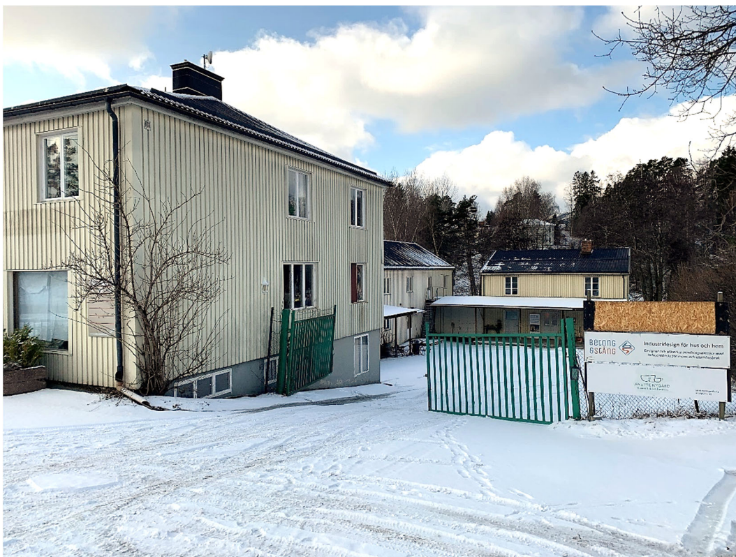
Berga 7:2 från öster med bebyggelsen ned mot vattnet.
