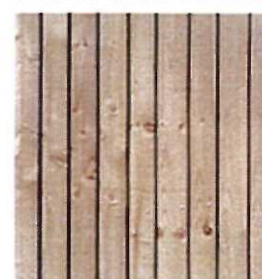
Träpanel i entréer
