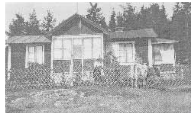
Äldre bild på torpets fasad mot vattnet.
