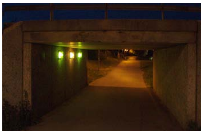
Befintlig tunnel i Åkersberga. Gamla armaturen "Anita" försedd med skyddsgaller och både kvicksilver- och högtrycksnatriumljuskälla. Se bilderna ovanför för förslag på förbättring!
