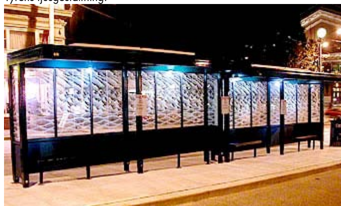
Busshållplats med solcellsdriven och rörelseaktiverad belysning. Carmanah Technologies.
