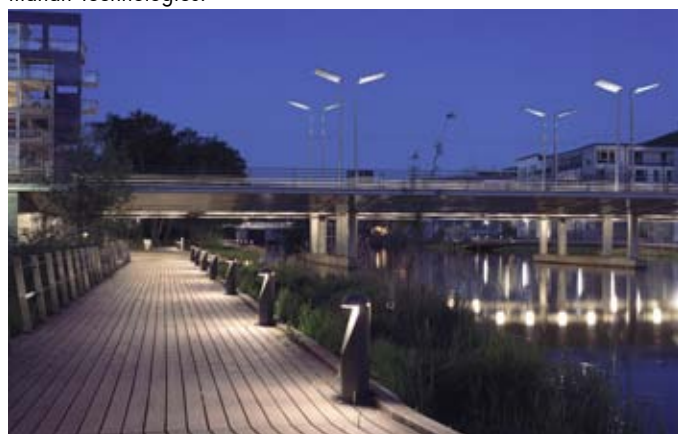
Avbländad pollarbelysning. Hammarby Sjöstad. Ljusdesign: Tyréns ljusgestaltning.
