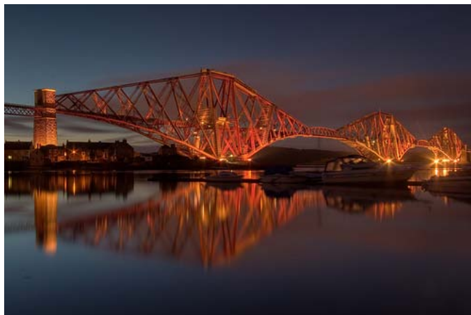
Forth Road Bridge i Edinburgh, Skottland. Stålkonstruktioner som i vanliga fall kan vara rätt tråkiga och funktionella, kan med ljussättning bli fantastiska blickfång. Foto: César Moral.
