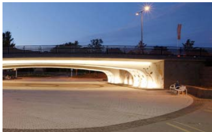
Inbjudande gångtunnel. Viertolan aukio. WSP Finland OY. Pia Salmi.
