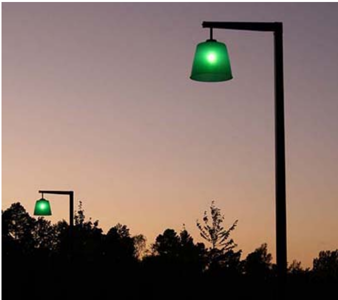
Dekorative armaturer vid Täby södra kyrkogård. Ljusdesign och foto: Helena Björnberg, Tyréns Ljusgestaltning.
