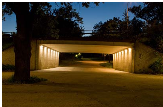
Tunnel i Älvsjö. Ljusdesign: Tyréns ljusgestaltning.
