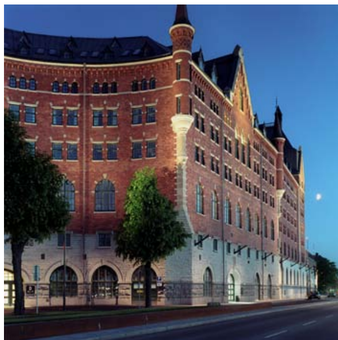
Münchenbryggeriet, Stockholm. Dämpad och funktionell fasadbelysning som inte konkurrerar med byggnader högre i hierarkin i samma område. Ljusdesign: Tyréns ljusgestaltung.
