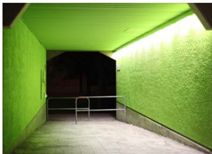
Effektfull, grön portal. Innergård, Stockholm. Ljusdesign: Kristian Gedal, Tyréns ljusgestaltning
