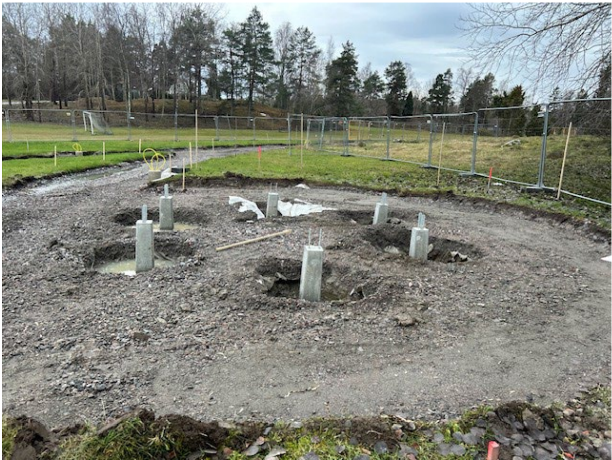
Fundament till grillhus
