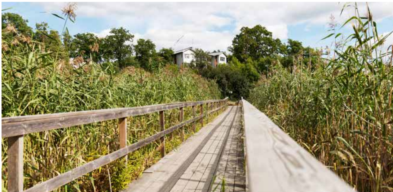
Gångbro vid Åkers kanal.
