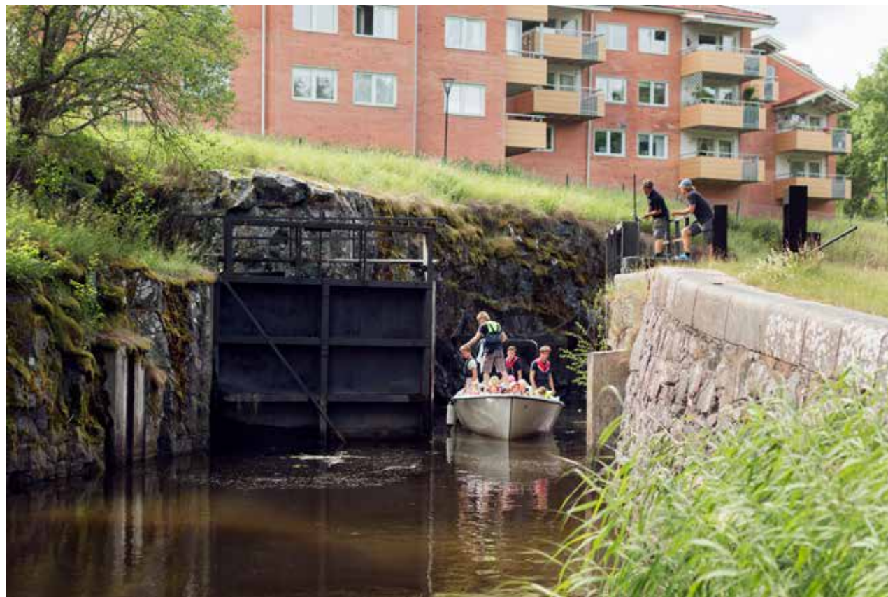
Slussen i Åkers kanal.
