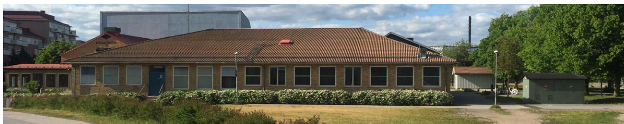
Berga teater är en del av Kulturknuten och inryms i en byggnad som delas av fritidsgården Bergagården. Dessa är belägna i södra delen av programområdet intill Åkersberga centrum.
