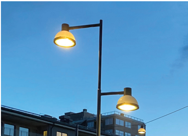
Exempel på belysningsarmatur med en högre och en lägre del. Light Bureau
