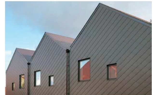
Exempel på byggnad med samma tak- och fasadmateriel.
