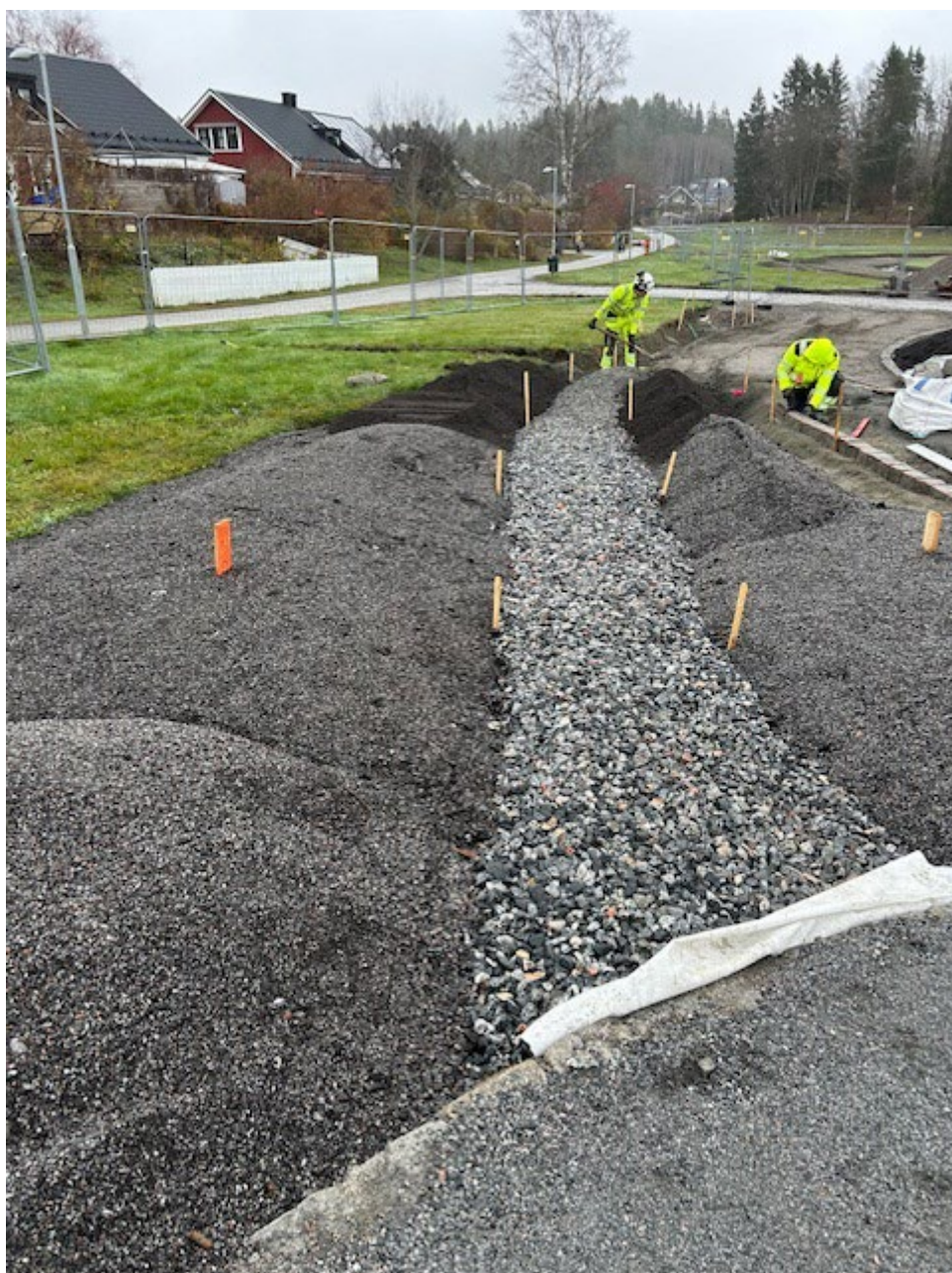
Uppbyggnad av växtbäddar och sättning storgatsten
