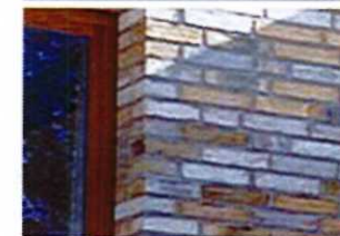
Fönster placeras en bit in i fasadlivet
