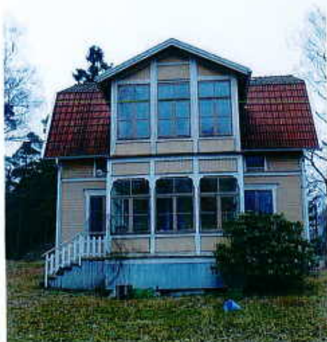
En klassisk herrgårdsbyggnad med en symetrisk byggnadsplan. Villan har frontespis och stor glasad veranda på den sida som vetter mot vattnet.
