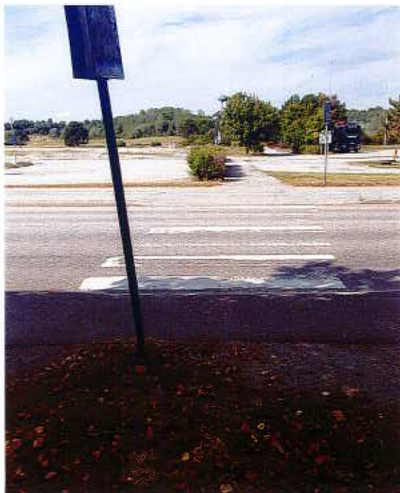
Brist: Oreglerat övergångsställe saknar tillgänglighetsanpassning. Åtgärd: Övergångsstället tillgänglighetsanpassas genom sänkt kantsten för rullstol och kontrastplattor för synsvaga.
