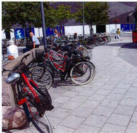
Brist: Bristande ledstråk för synnedsetta på grund av oorganiserad cykelparkering. Åtgärd: Cykeluppställningen byggs in och ledstråk anläggs.
