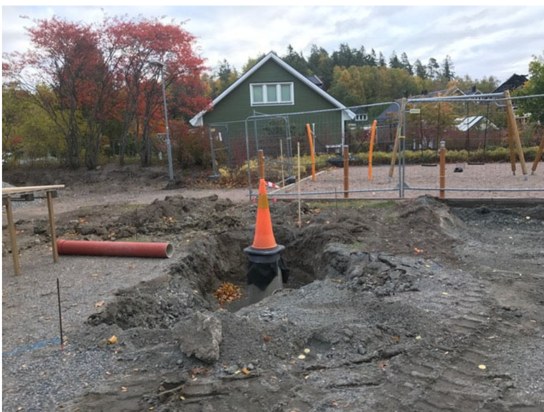
Här kommer en belysningsmast monteras.
