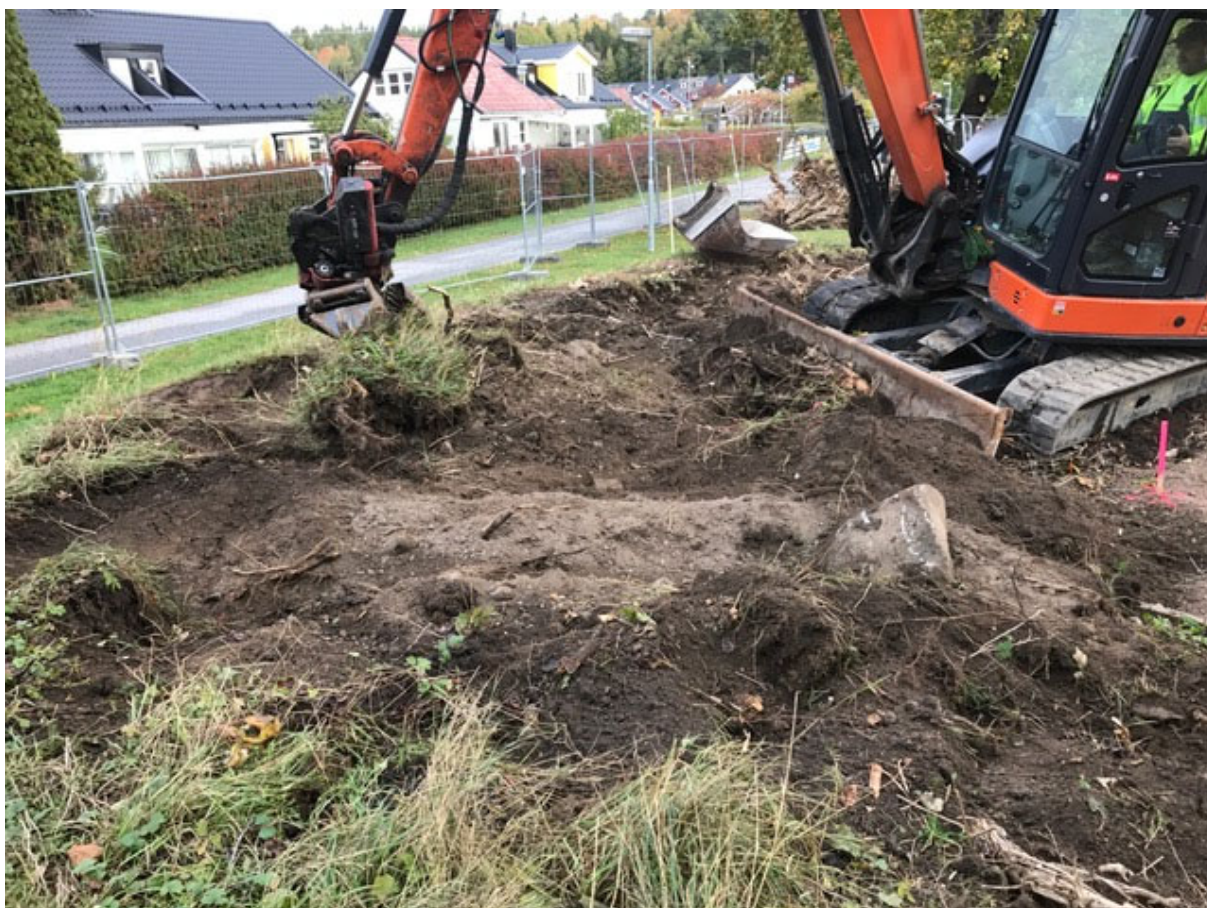
Borttagning material i befintlig kulle på plats. Den rosamarkerade pinnen vid grävmaskinen markerar "toppinnen" på den blivande snigelkullen.
