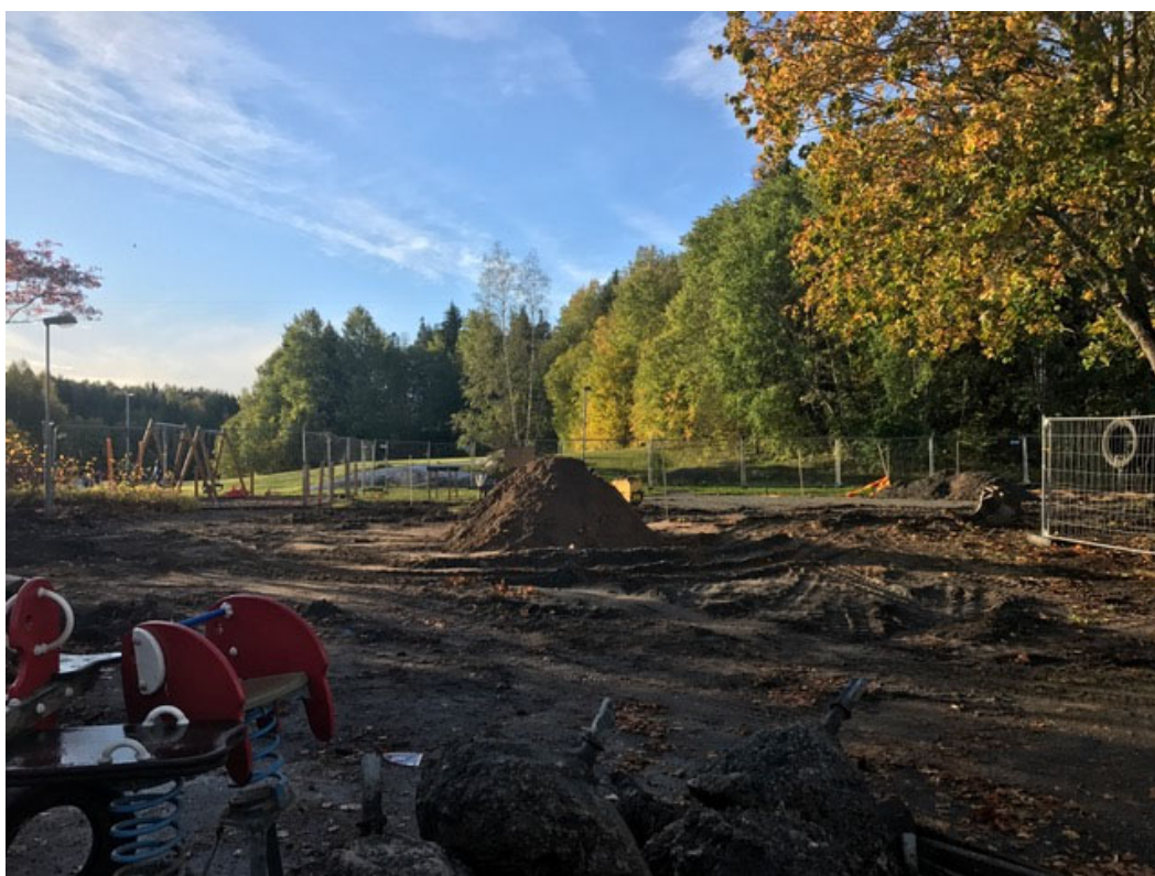
Befintlig lekutrustning tas bort
