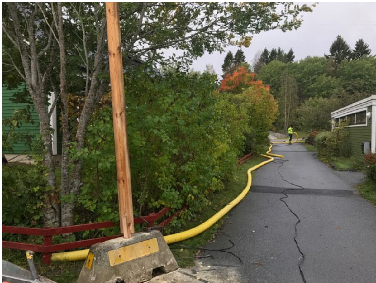
Ned till i bild syns schaktgropen för en av belysningstolparna
