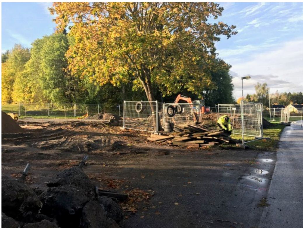
På bilden ses allt rensat imoregnerat virke som ska deponi. Bakom denna syns skyddsinnhägnad kring den befintliga lönnen.
