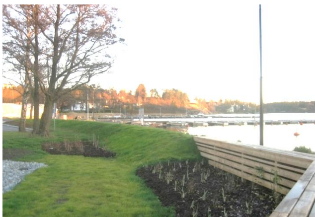
Figur 4 Vall som teknisk skyddsåtgärd (Foto: Danderyds kommun)
