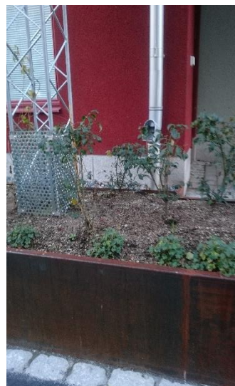
Figur 7 Utkastare för takavvattning i Norra Djurgårdsstaden (Foto: Christina Frost)
