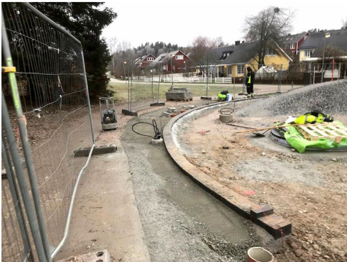
Uppackning för start sättning marksten.
