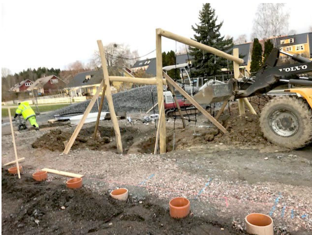
Uppriggning robiniastolpar i parkourutrustningen. Materialet som schaktas upp köra på deponi.
