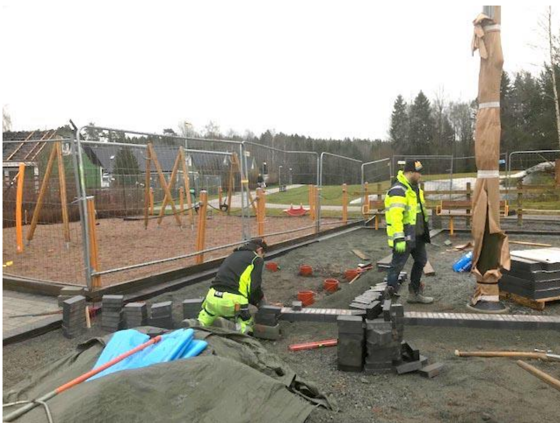
Marktegelsättning i jf-betong.
