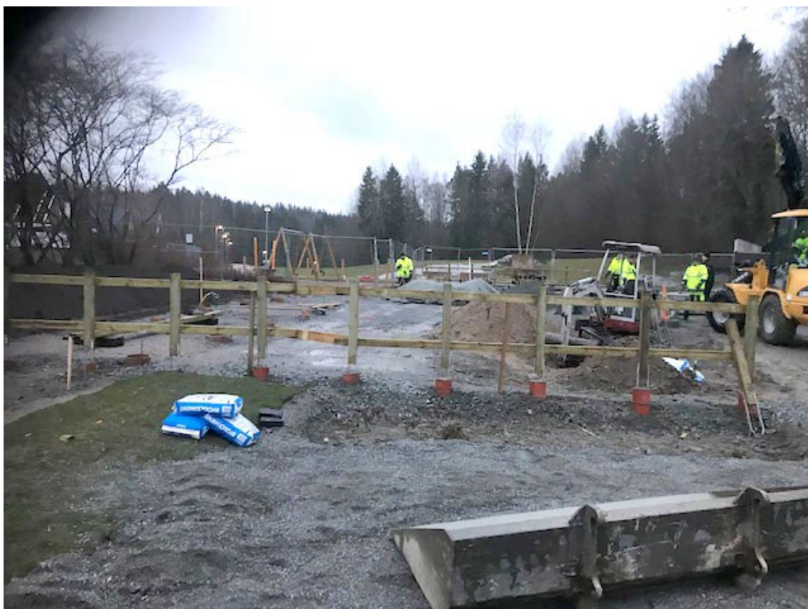
Parkouren efter gjutning. I nederkant syns också start med markstensläggning.
