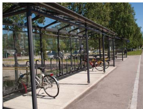
Exempel på cykelparkering i anslutning till kollektivtrafik, Helsingfors
