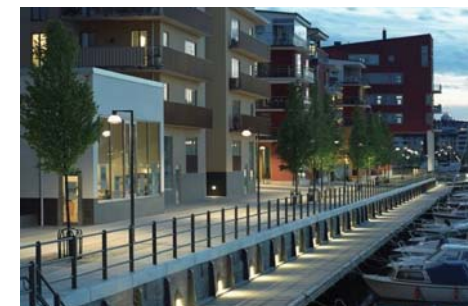
Exempel på kaj med båtängöring, Hammarby Sjöstad.
