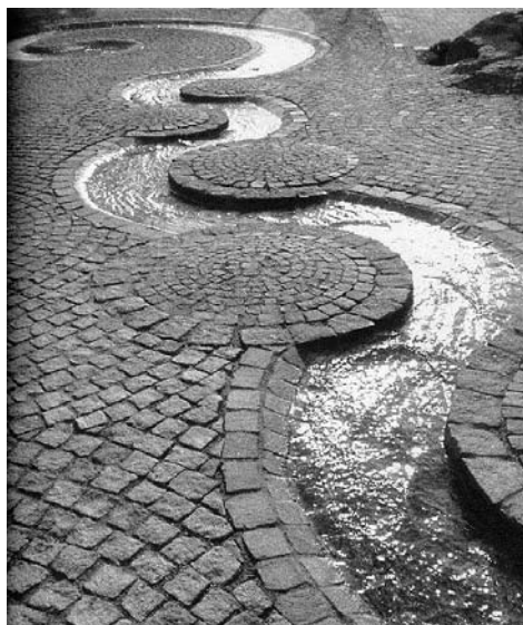
Exempel på stadsmässig lösning för dagvatten.
