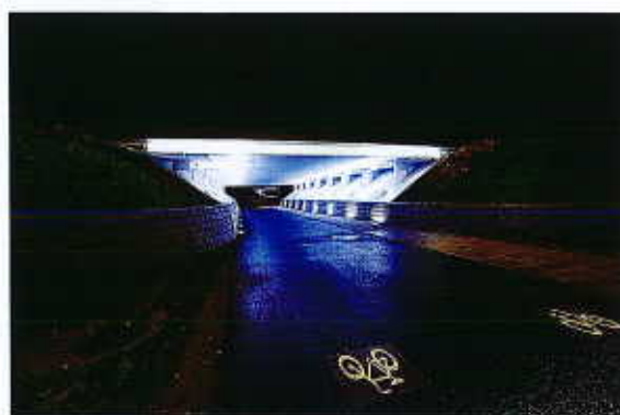
Figur 4-1 Exempel på gång- och cykeltunnel i Linköping. Gående och cyklister är separerade genom olika markbeläggning, tunneln är belyst och sidoområdena röjda vilket skapar god sikt. Källa: www.tindradesign.nu
